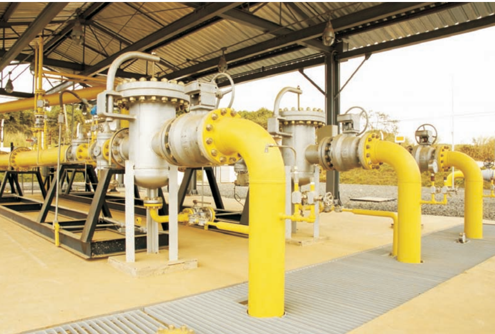
SEGURANÇA. Estação de controle de pressão primária e centro de controle da Gas Natural: segurança é um dos diferenciais dessa matriz energética
