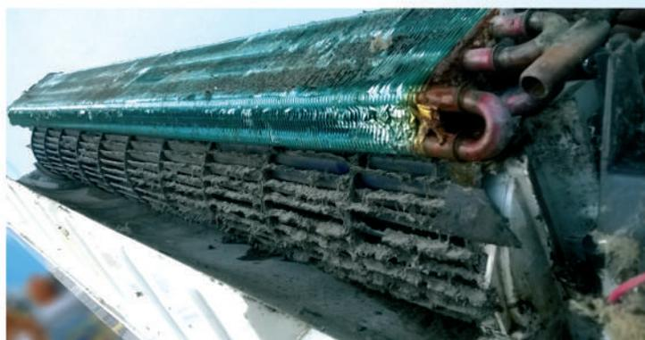
Unidade interna de um aparelho de ar-condicionado contaminado com poeira, fungos e bactérias
