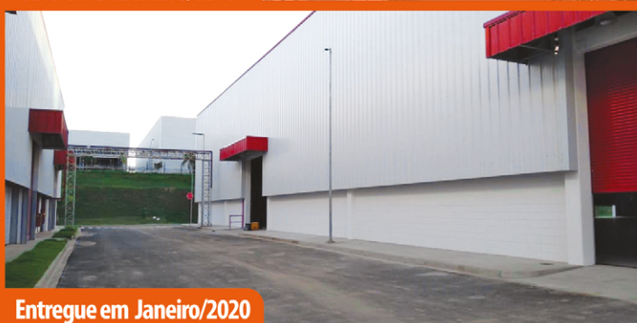
Obra em Dezembro/2019
